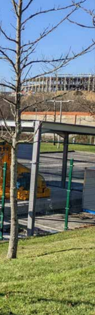
Instalaciones de H2Sarea en Zamudio (Bizkaia)
